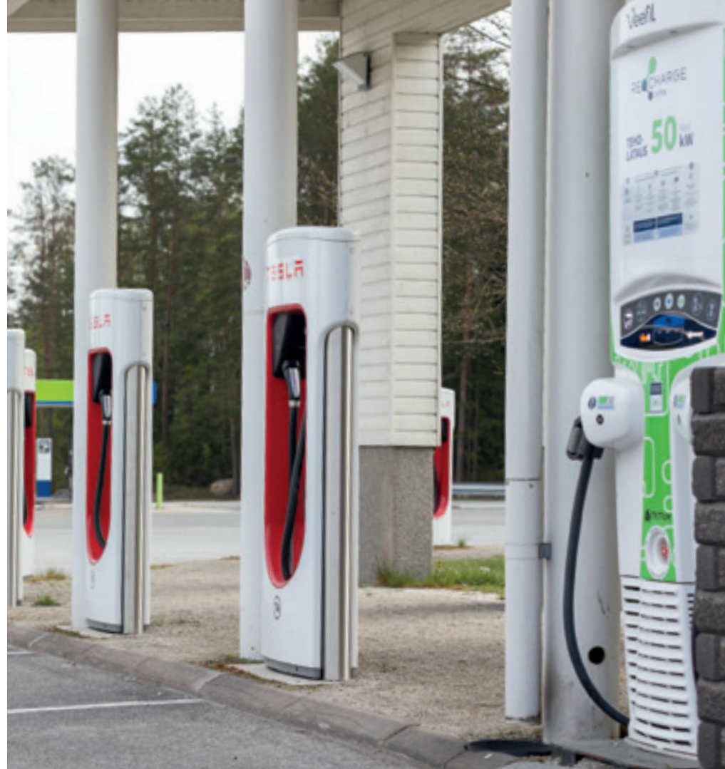
Teslan suurteholaturit Jalasjärvellä ja Kuopiossa (rakenteilla).
